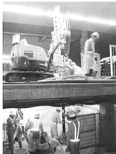
写真-2 削孔状況
