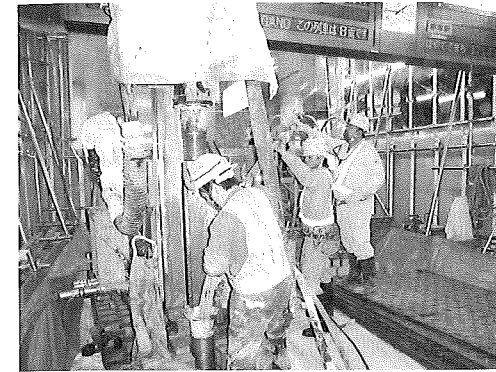
写真-3 テンドン挿入状況
