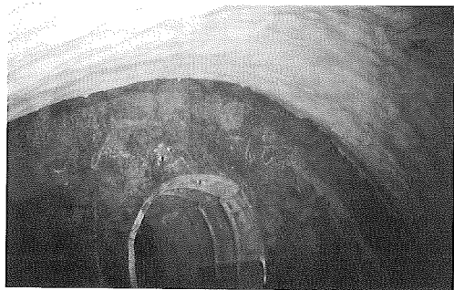
写真-2 上半吹付け仕上がり状況(吹付け厚 t = 50\text{cm} )
