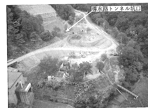
写真-2 導水路坑口ヤード
