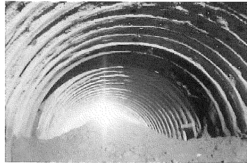
写真-11 貫通発破直後の切羽
