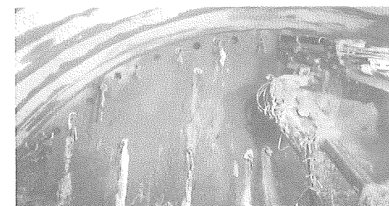
注入式長尺先受工法 (AGFI工法)
