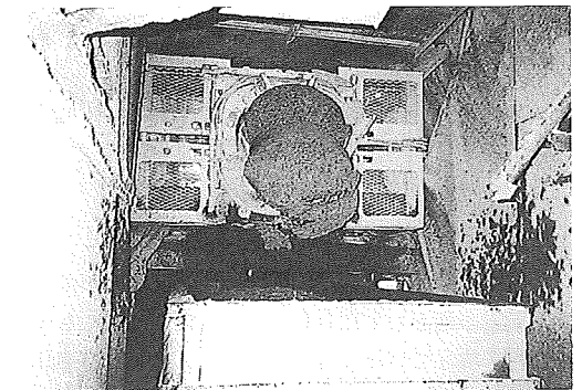
写真-3 現場排土状況
