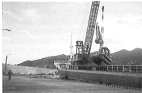
写真-1 使用資機材海上輸送
