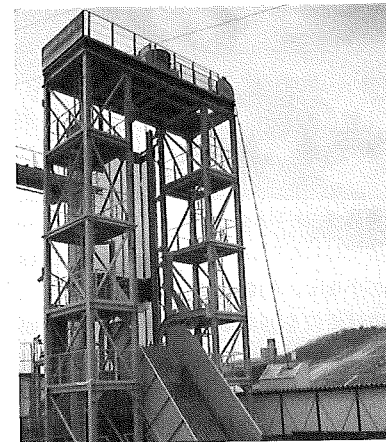
写真-1 スキップ地上槽設備
