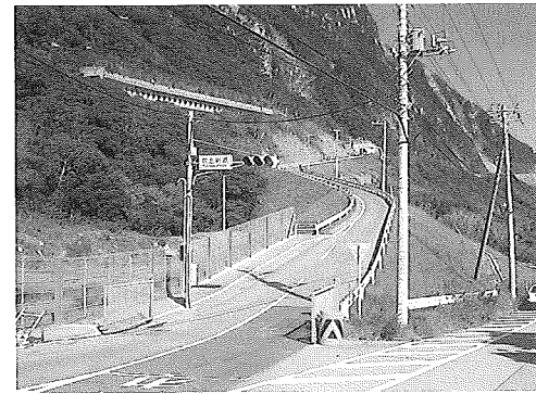
写真-2 楡山地区仮設道路
