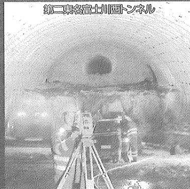
第二東名富士川圏トンネル
