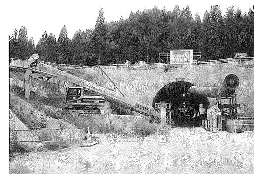
写真-1 坑口全景
