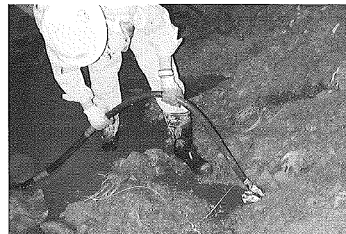
写真-5 下半装薬状況
