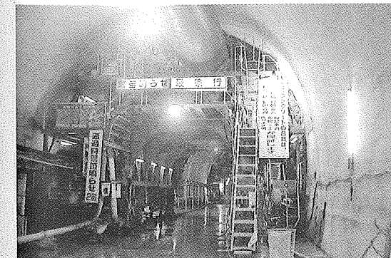
覆工セントルセット状況
