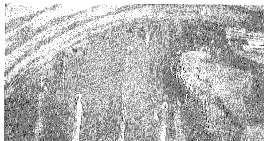
注入式長尺先受工法 (AGF工法)
