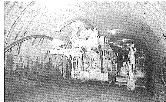
吹付けロボット一体エレクタ台車
