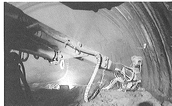
二次吹付け状況
