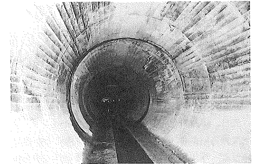
写真-4 補修完了
