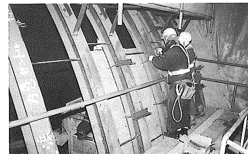
写真-3 背面側でのパネルの固定状況
