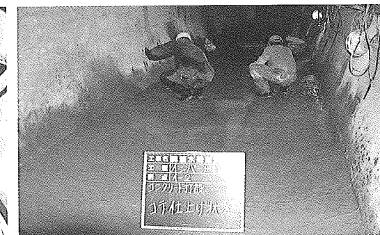
インバートコンクリートこて仕上げ状況
