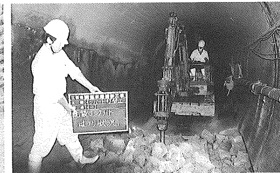
既設インバートはつり状況
