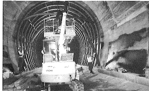
写真-2 放水路トンネル補強工(支保)
