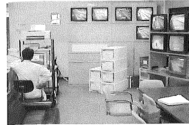
写真-6 道路公団事務所での監視状況
