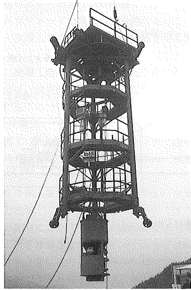
写真-4 スカフォード(一次覆工)
