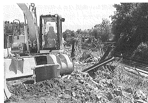
写真-2 コルカストリート換気立坑・基地造成
