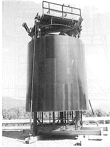
写真-5 スカフォード(二次覆工)
