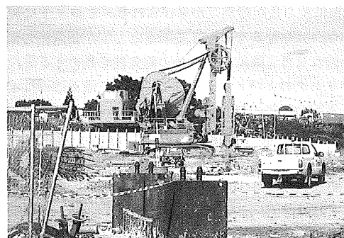
写真-1 発進立坑工事(230工区)
