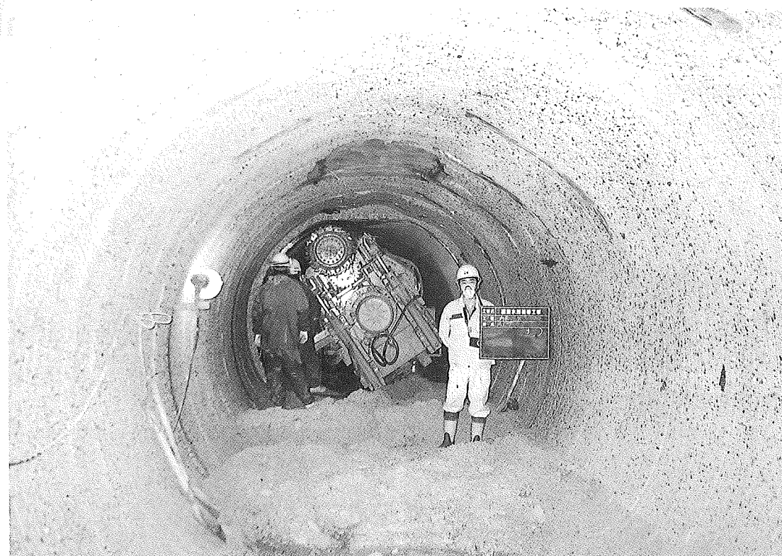
切削完了状況
