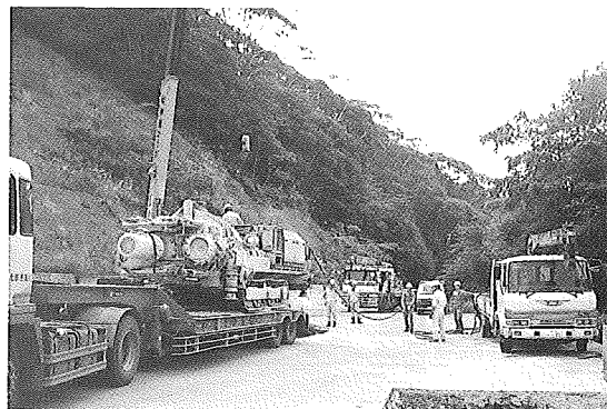
はつりロボット搬入状況
