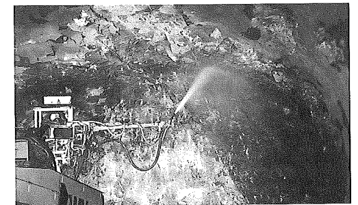
写真-2 吹付け前の水洗い状況(ノルウェー)
