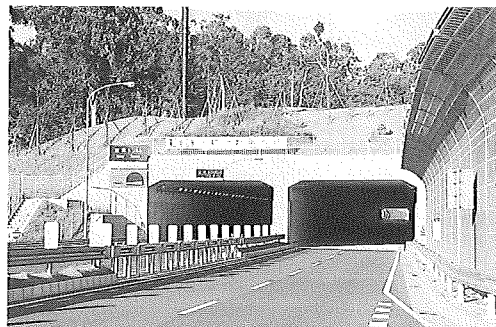
写真-10 宝来トンネル
