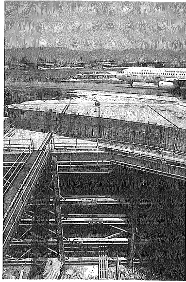
写真-13 台湾松山機場発進立坑
