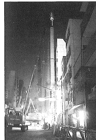
写真-6 柱列式鋼管矢板建て込み状況
