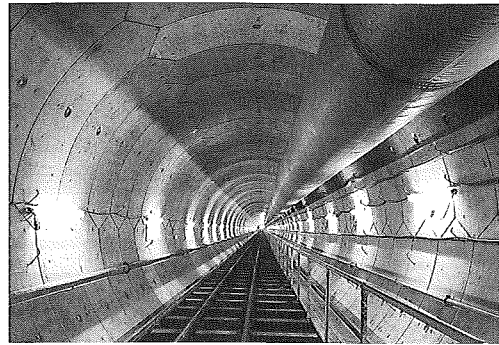
写真-2 出来形状況(月島シールド)
