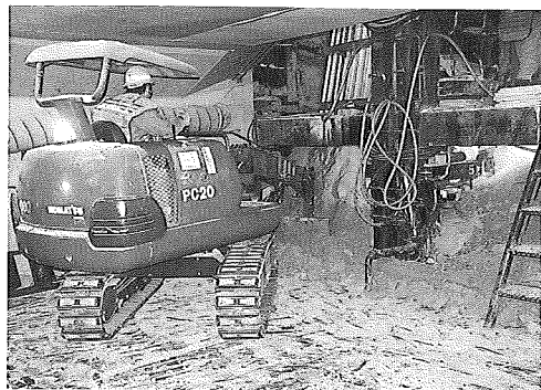
写真-8 切羽掘削中
