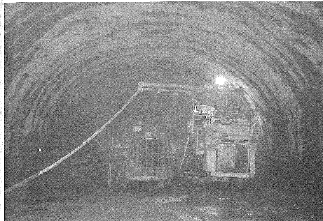
掘削およびずり出し状況
