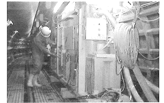
写真-1 坑内プラント設置状況
