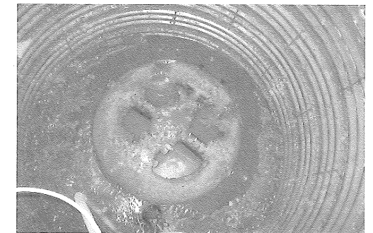
写真-1 シールド到達状況
