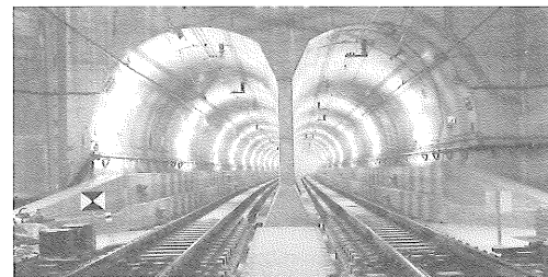
写真-2 二連型MFシールドトンネル
