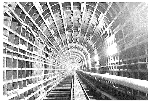
写真-2 一次覆工完了状況
