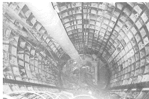
写真-5 坑内掘進状況
