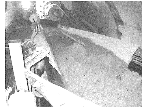
写真-6 土砂排出状況
