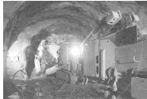
写真-4 積み込み状況(1)
