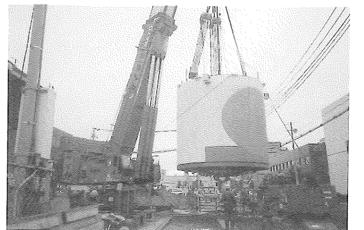
写真-3 シールド組み立て状況
