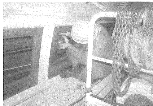
写真-4 押し出しジャッキ盛り換え状況
