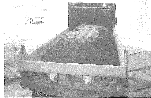
写真-7 残土搬出状況
