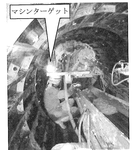
写真-3 マシンターゲット設置状況
