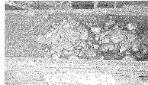
写真-1 添加材が適合しない場合 (ゲートから噴発・排土は分離状態) 地盤の礫率80%、透水係数 10^{-1} cm/sec
