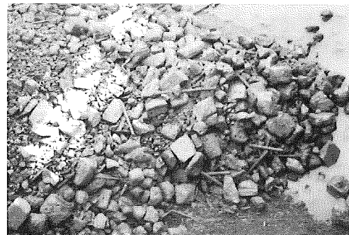
写真-1 大割れしたNOMST部材
