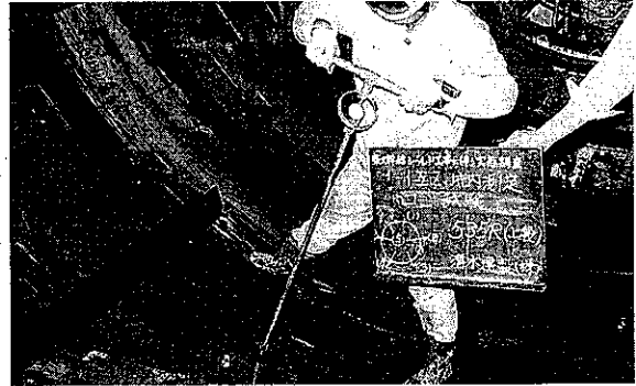
写真-1 一次覆工外周の乱れ範囲調査(ポータブルコーン貫入試験)
