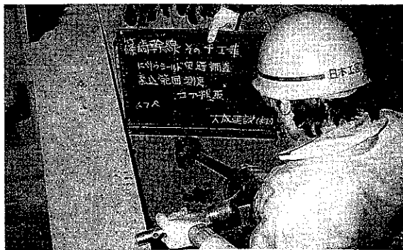
写真-2 裏込め注入状態調査(コアサンプリング)
