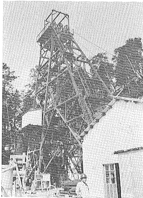
写真-1 立坑全景
