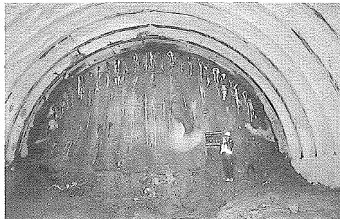
写真-10 AGF施工1シフト完了
