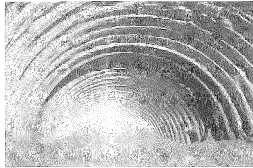
写真-11 貫通発破直後の切羽
