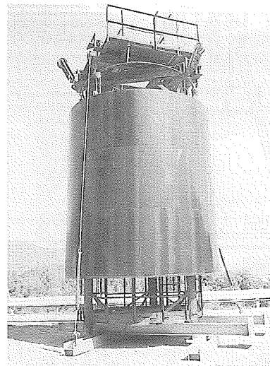
写真-5 スカフォード(二次覆工)
