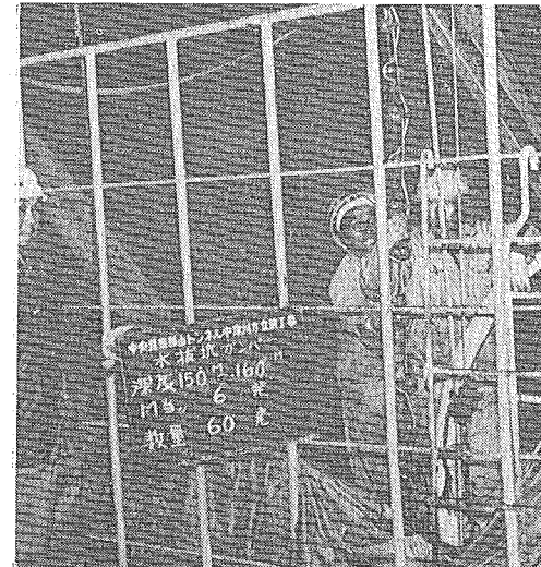
写真-2 孔明工事の状況
