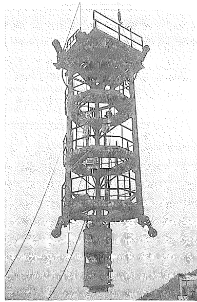
写真-4 スカフォード(一次覆工)
