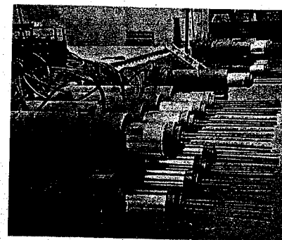
写真-6 作動中のフロンテジャッキ
