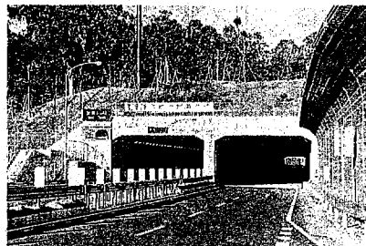
写真-10 宝来トンネル
