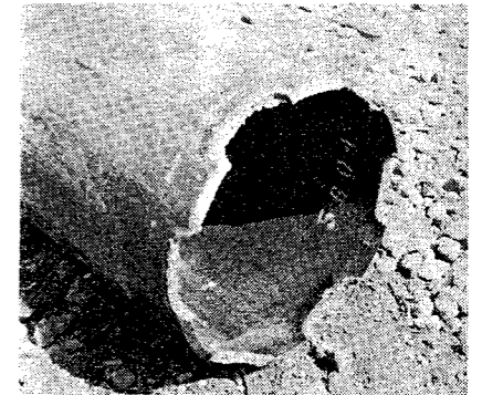
写真-9 鋼管刃口
