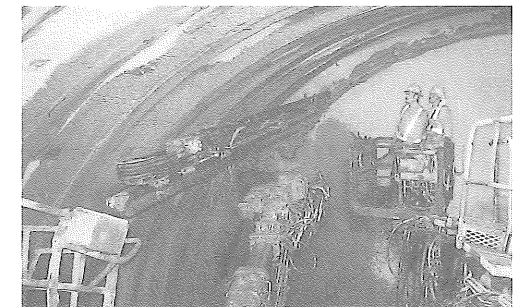
写真-1 鋼管打設
