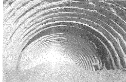
写真-11 貫通発破直後の切羽
