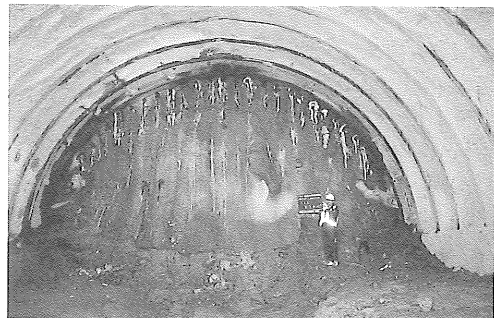
写真-10 AGF施工1シフト完了
