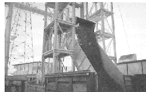
写真-2 スキップずり揚げ状況
