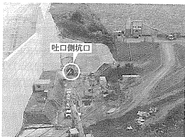
写真-1 吐口側坑外設備ヤード
