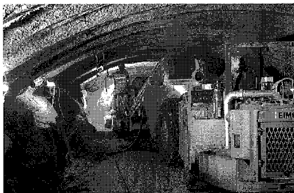
写真-2 ずり積み出し状況
