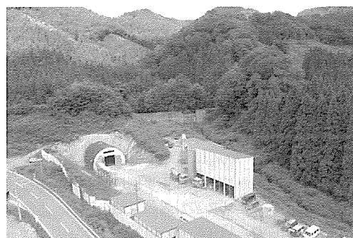
写真-9 坑口環境対策 (金山町坑口環境対策状況を空撮)
