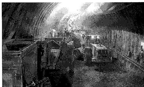
写真-10 クラッシャーのずり投入状況
