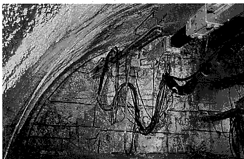
写真-3 上半部 SD機によるスロット削孔状況
