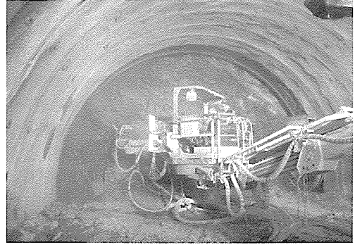
写真-2 エレクト付き一体型吹付け機による吹付け状況
