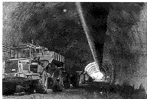
写真-10 鋼製支保なしの区間の吹付け状況。風管の影(右上)にほとんど凹凸がない滑らかな吹付け面。
