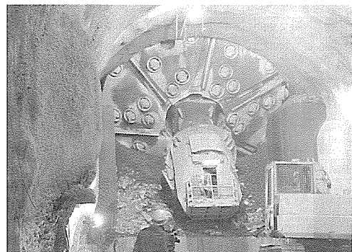
写真-3 貫通時におけるリーミングTBM
