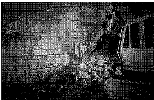
写真-4 大型ブレーカによる直接掘削状況
