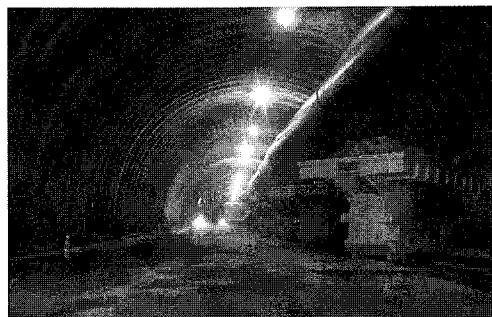
写真-9 坑内仮置き状況
