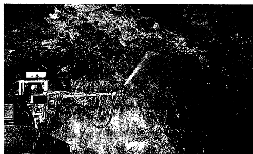
写真-2 吹付け前の水洗い状況(ノルウェー)
