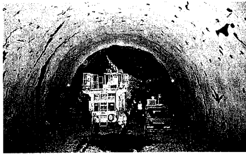
写真-3 ドリフター自動制御によるドリルジャンボ
