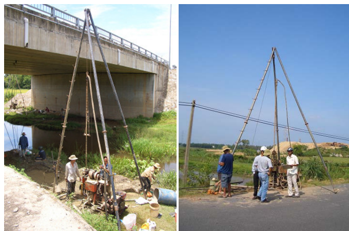
写真 2-1 ボーリング調査実施状況
