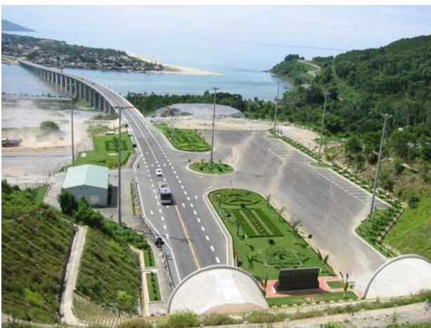
図-9 ハイバントネルの北側坑口(フエ側)
