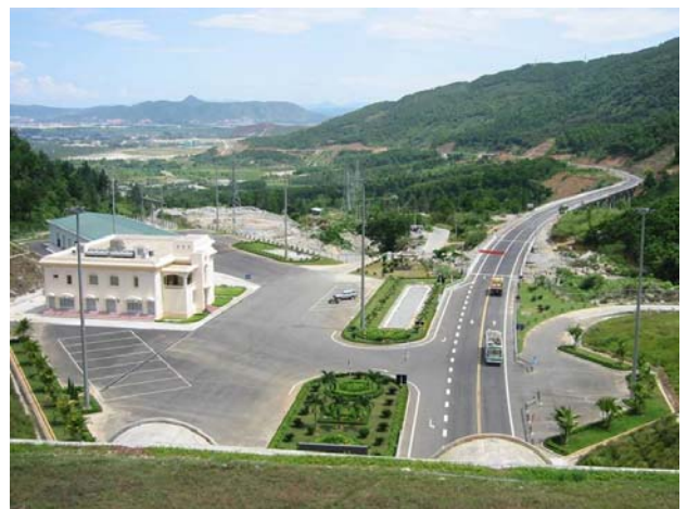
図-11 南側坑口のトンネル管理センター
