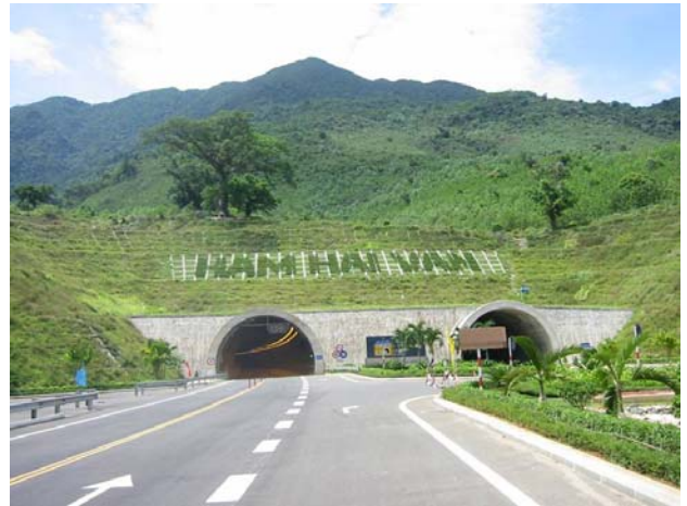
図-10 ハイバントネルの南側坑口(ダナン側)
