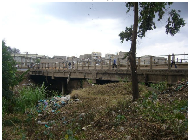
10. Githathuru River を横断する橋梁
