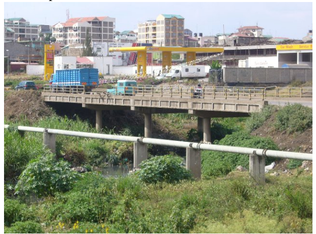
4. Ngong River を横断する橋梁
